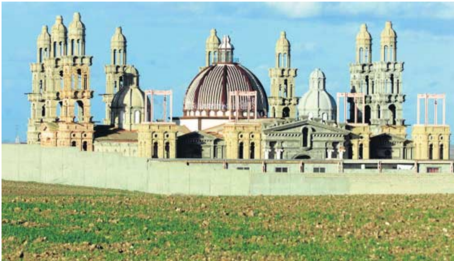
El templo de la secta El Palmar de Troya, cercado por una muralla de hormigón de varios metros de altura.
